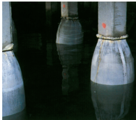
Pilotes de concreto reparados con "chaquetas" y concreto tratado con el aditivo RHEOMAC UW 450.
