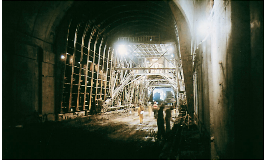
Proyecto de tunel que requirió vaciado de concreto bajo el agua
