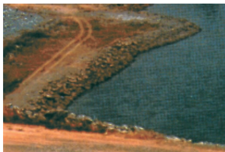
Cortina de grout construida utilizando concreto tratado con el aditivo RHEOMAC UW 450.
