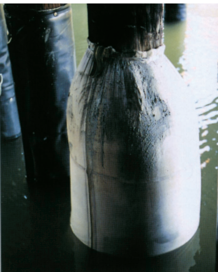
Pilotes de madera reparados con "chaquetas" y concreto tratado con el aditivo RHEOMAC UW 450.
