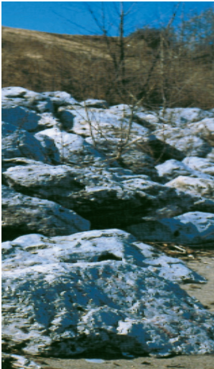
Zona rocosa antes de asegurarse con grout tratado con RHEOMAC UW 450.
