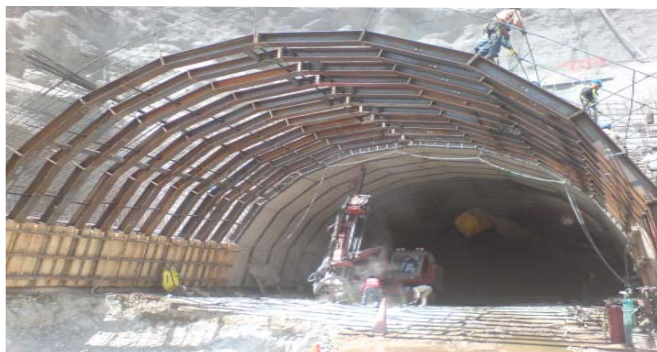
Concreto lanzado con MEYCO® SA 160
