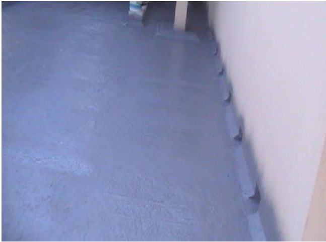
Aplicación de IC-2480 ya terminada
